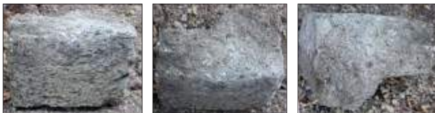
F. N6. Corner stone. Length – 0,3; width – 0,2; height – 0,22 m. Hall church (building VI).
