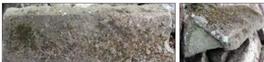
Пол. Ном-5. Конек. Местная скальная порода. длина-0,65; высота крыльев- 0,18; 0,19; толщина основания-0,24 Зальная церковь (строение VI).
