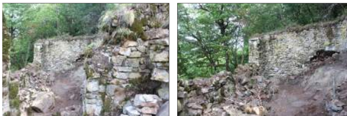
рис. 61,62. Трапезная после снятия растительного покрова и земли. Фото Т. Бибилури
