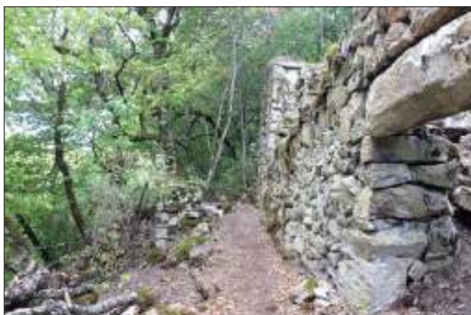
рис. 45. Стена N снаружи со стороны NW.
