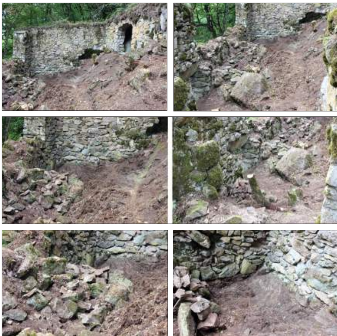
рис. 55-60. Трапезная на различных этапах работ. Фото Т. Бибилури
