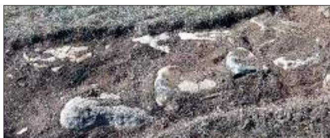
рис. 88,88-а. Сельбище Вицха. Участок. дом N 2, детали кладки стены
